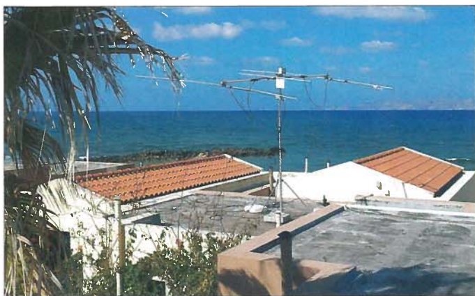
Aufgrund von Leichtbauweise und kurzem Standrohr benötigte die Konstruktion keine Abspannung. Ein paar Gewichte an den Füßen des Home-made-Tripods genügten völlig für Stabilität und Windfestigkeit.
