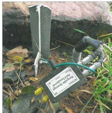
Bild 5: Lösung des Erdungsproblems; Kreuzstabender mit Lasche am BOG-Speisepunkt Fotos: DL1AMQ
